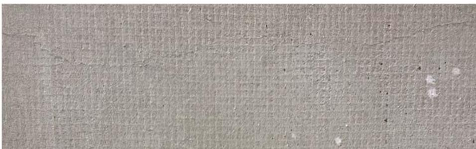
Ejemplo de Base Coat razonablemente bien aplicada. En este caso se observa la trama de la malla de refuerzo, pero no se aprecia color de esta y, al haber sido verificada en terreno, no se sentía el entramado al tacto.
